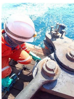
รูปที่ 3-40 การซ่อมบำรุงและการเปลี่ยนเส้นท่อ
