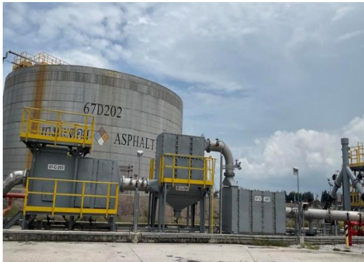
รูปที่ 3-6 ระบบควบคุมไอระเหยจากท่อระบาย ของถังเก็บกักขางมะตอย
