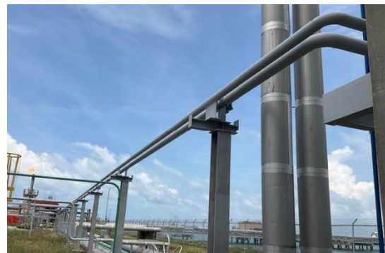
รูปที่ 3-3 ท่อรวบรวมไอน้ำผลิตภัณฑ์และวัตถุดิบ ที่เกิดจากกิจกรรมการขนถ่ายไปยังหอเผา (Flare)
