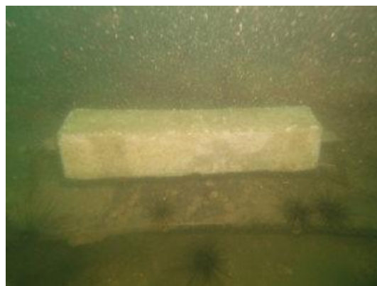
รูปที่ 3-39 ระบบป้องกันการกัดกร่อน
