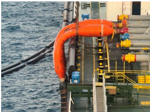
รูปที่ 3-37 อุปกรณ์รองรับน้ำมันหกบริเวณใต้รอยต่อของท่อที่เรือบรรทุกน้ำมัน
